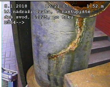
FOTO14: Prasklina tvarovky vstupu
