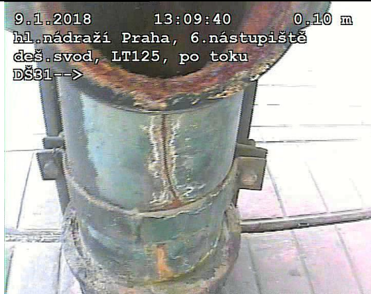
FOTO22: Prasklina vstupní tvarovky
