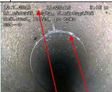
FOTO81: Prasklina podélná + příčná
