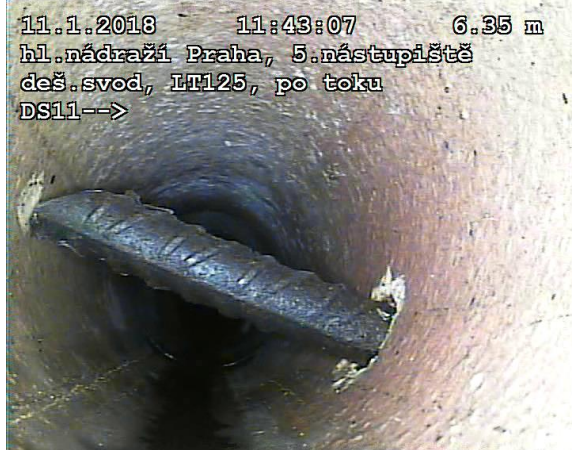
FOTO63: Potrubí proraženo roxorem
