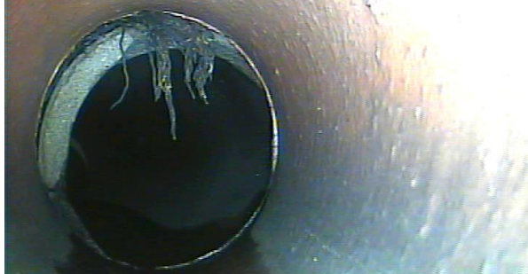
FOTO116: Spoj posunutý netěsný
