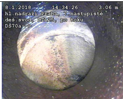
FOTO: Posunutý spoj trub
