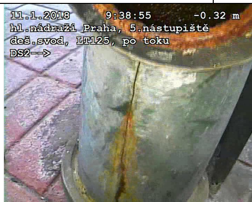
FOTO74: Prasklina tvarovky vstupu
