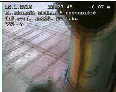
FOTO80: Prasklina tvarovky vstupu
