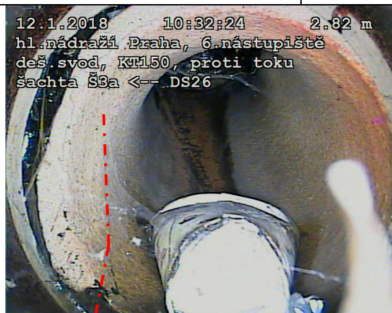
FOTO90: Cizí předmět ve spoji spadiště
