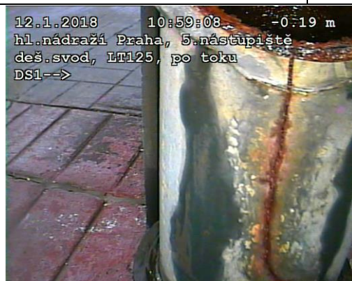
FOTO77: Prasklina tvarovky vstupu
