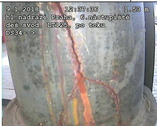
FOTO26: Prasklina tvarovky vstupu
