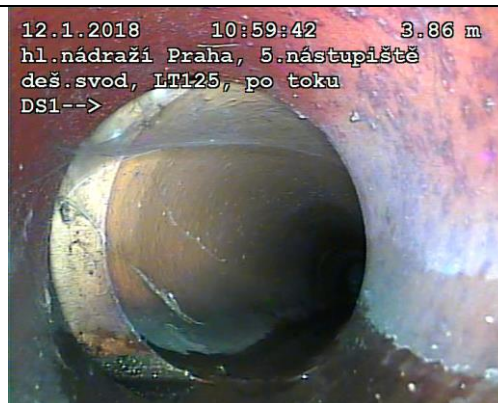
FOTO78: Nepřesně provedené spoje trub v úhlu
