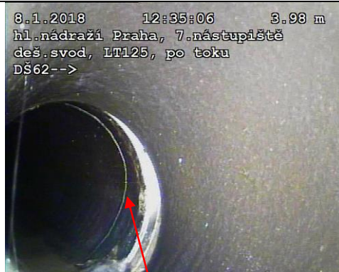
FOTO12: Prasklina u spoje pod spadištēm
