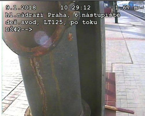
FOTO44: Prasklina tvarovky vstupu
