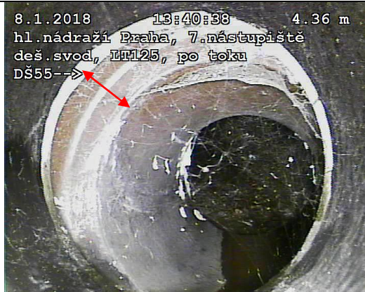
FOTO4: Nepřesný posunutý spoj trub
