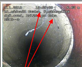
FOTO49: Praskliny vpravo u spoje
