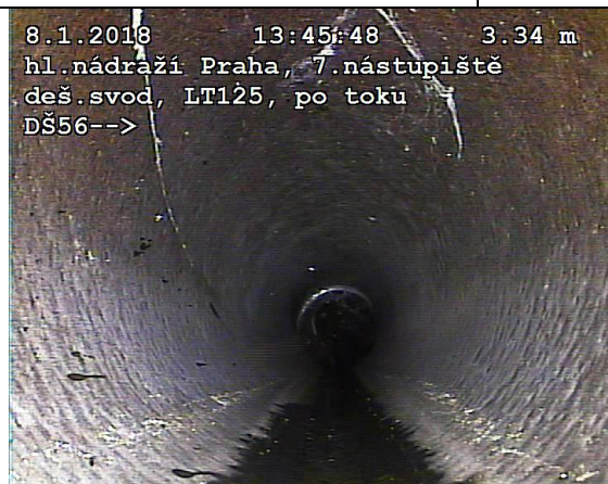
FOTO: Praskliny v horní části roury
