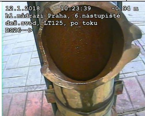
FOTO86: Prasklina a vylomená tvarovka vstupu
