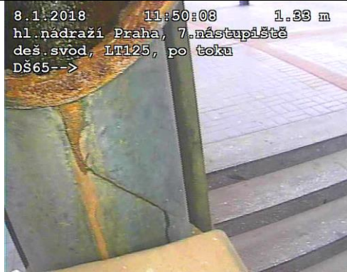
FOTO17: Prasklina tvarovky vstupu
