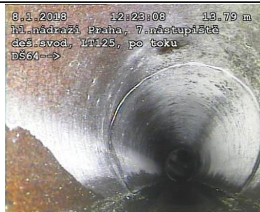
FOTO16: Prasklina před napojením na Š47
