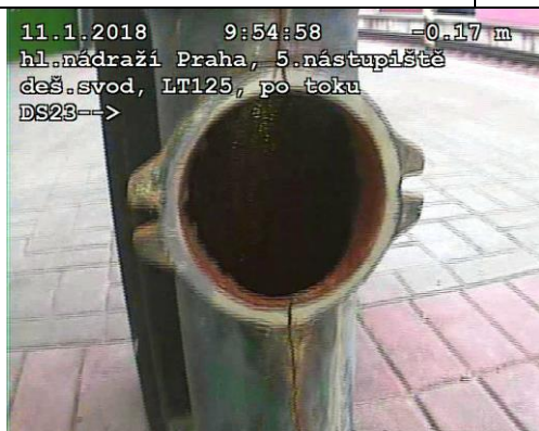
FOTO73: Prasklina tvarovky vstupu
