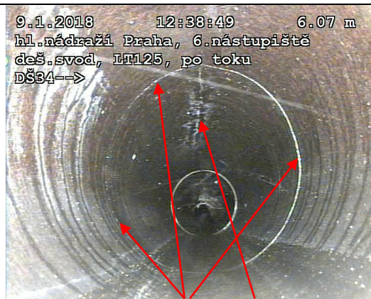
FOTO27: Praskliny příčná a podélná
