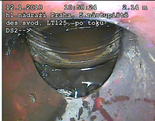
FOTO79: Spoj trub ve velkém úhlu, netěsnost
