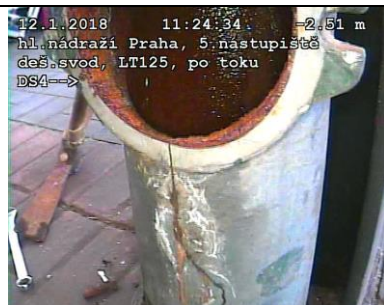
FOTO80: Prasklina tvarovky vstupu
