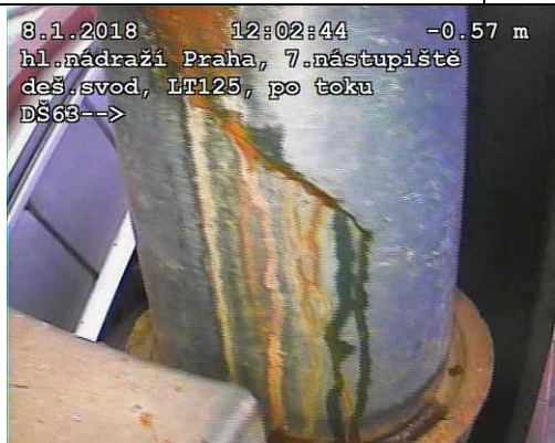
FOTO13: Prasklina tvarovky vstupu
