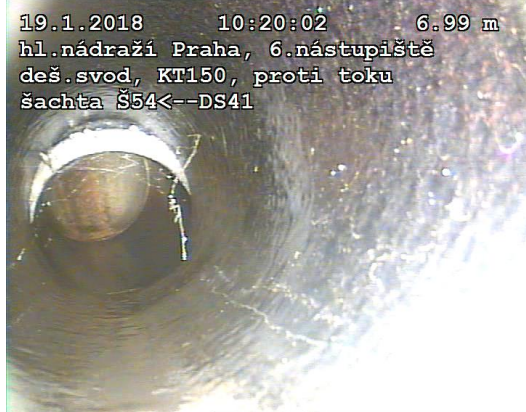
FOTO114: Nepřesný posunutý spoj
