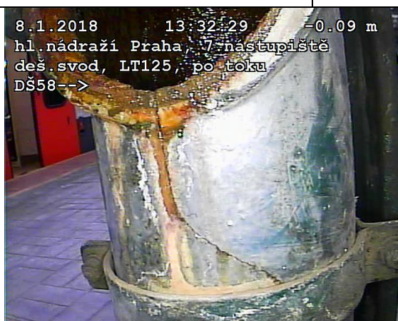
FOTO7: Prasklina vstupní tvarovky
