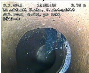
FOTO47: Posunutý spoj, vyčnělý provazec
